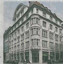
Das 1912/13 gebaute Schrödterhaus wurde seit 2008 saniert
